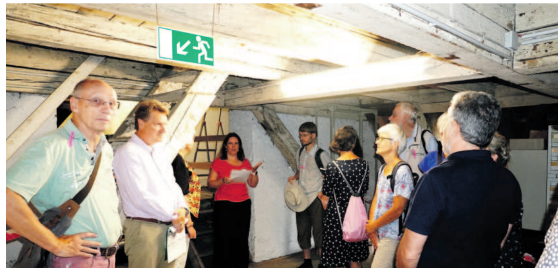
Unter dem Dachstuhl ist das Alter des Hauses besonders gut erkennbar.
